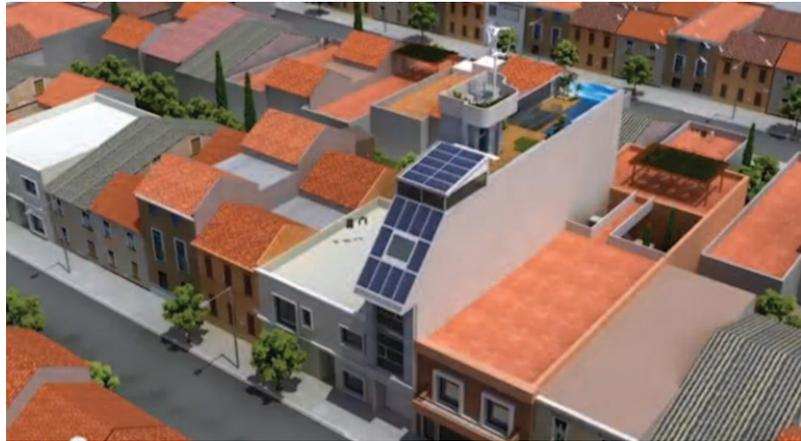
agua circulante que absorbe hasta el 70% de la radiación solar en verano y se refrigera a través de un pozo de agua fresca ubicado en el circuito. En invierno, la circulación del agua se detiene y el agua depositada en la cámara se calienta con el sol. Además, un sistema combinado de tejado fotovoltaico y turbina eólica logra satisfacer el consumo eléctrico y de ACS de la vivienda.
