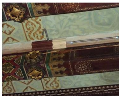
Comedor. Prueba del trazado de la instalación de agua nebulizada por el techo de la sala, y del cajeadado a realizar en las molduras originales de madera que camuflaran la instalación
