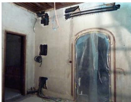
Foto izquierda: Incorporación de los conductos aislados de agua fría y caliente, aprovechando la doble cámara que se localizó en las portadas de acceso a las habitaciones de Antonio y Teresa Amatller.
