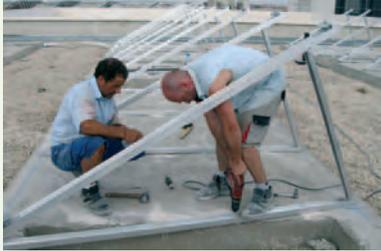
Instalación de los soportes para una batería de captadores
