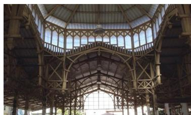
las tradicionales técnicas constructivas en madera y las nuevas tendencias con hierro. Según el Ayuntamiento, "el resultado final fue una estructura construida en madera pero con una solución arquitectónica propia de una construcción en hierro".
